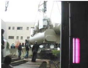
Rigging 1,200 Ton Chiller
